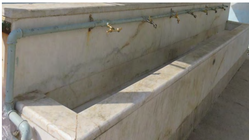
شکل ۶ - شیر پیچی نصب شده بر روی سکوی یک مرکز آموزشی
