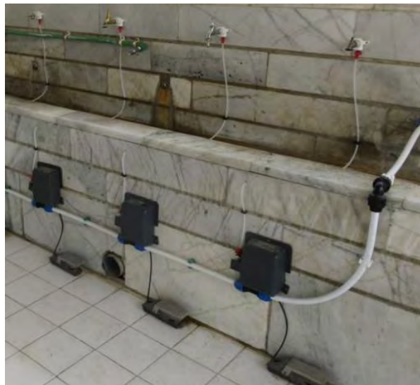
شکل ۲ - نمونه‌ای از شیر پدالی نصب شده بر روی سکوی مدرسه که به علت داشتن لوله و اتصالات روکار، آسیب پذیر هستند.
