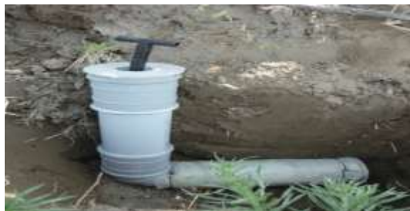
شکل ۱۱- نمونه‌ای از اجرای سامانه آبیاری قطره‌ای به همراه لوله PVC درجا
