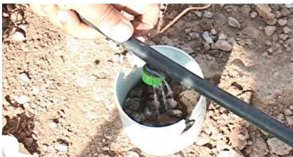
شکل ۱۰- تثبیت قطره‌چکان آبیاری در لوله PVC
