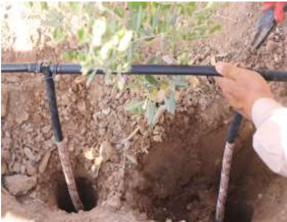
شکل ۴- نمونه‌ای از نصب لوله‌های تراوا
