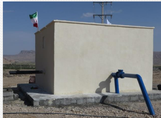
حفر و تجهیز چاه
